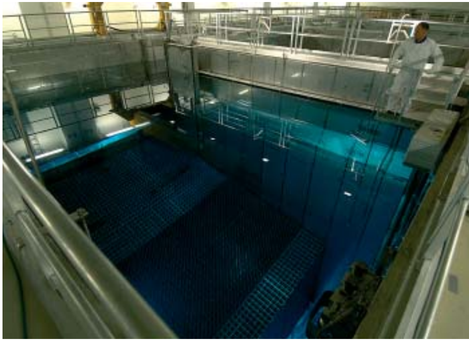
Vesi jäädyttää käytettyä polttoainetta ja toimii säteilysuojana. Polttoaineniput siirretään veden alla kuljetussäiliöstä varastoaltaan telineisiin, joissa niitä säilytetään loppusijoitukseen saakka.
