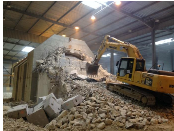
(d) Demolition of the low-pH SCC containment wall
