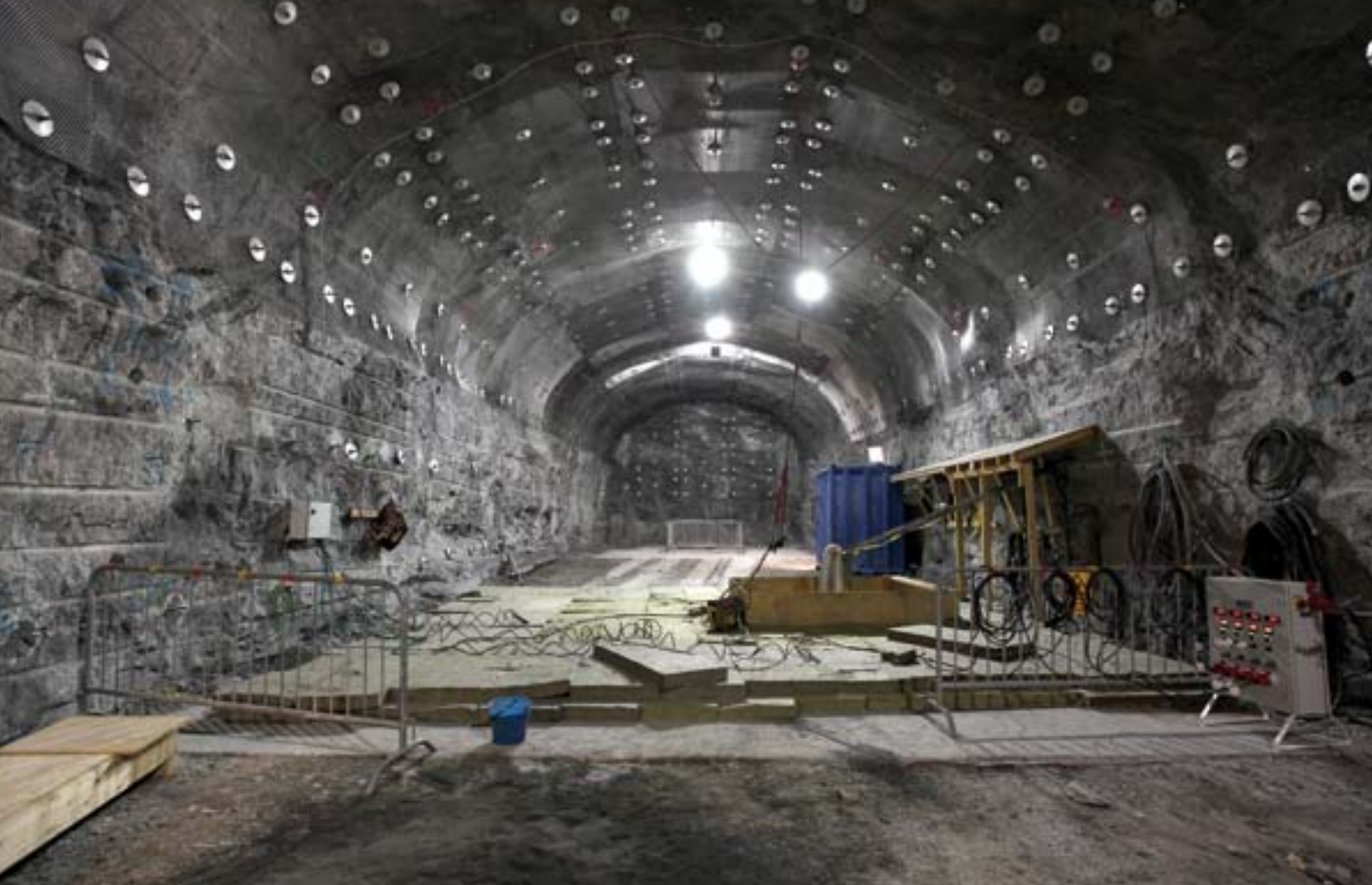
ONKALON tutkimustilassa 3 (Pose-kuprikka) tutkitaan lämmön vaikutusta kallion hilseilyyn tutkimustilan lattiaan poratuissa testirei'issä.
