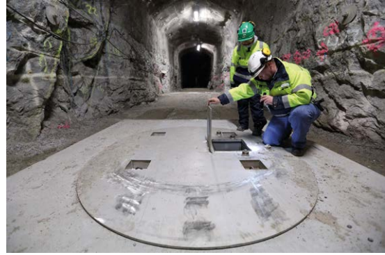
Loppusijoitusreiän tekoa on testattu ONKALOn demonstraatiotunnelissa.
