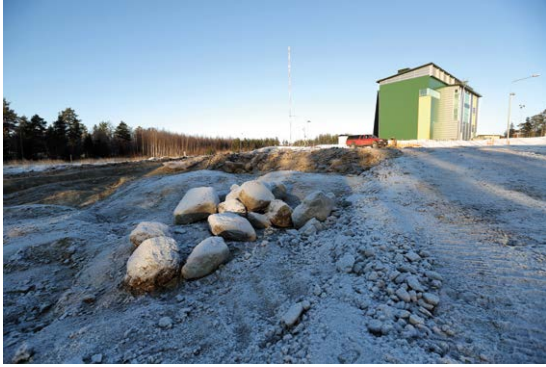
Aluetyöt etenevät tulevalla loppusijoituslaitoksen laitosalueella.
