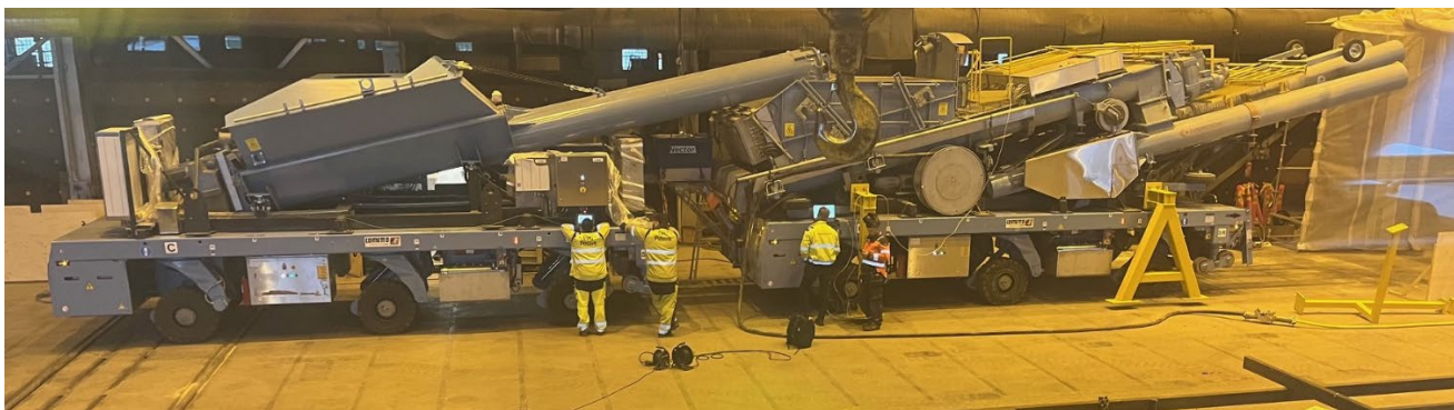
Kuva 4-9. GBIS-järjestelmän maanpäällisen täyden mittakaavan testien valmistelua.
